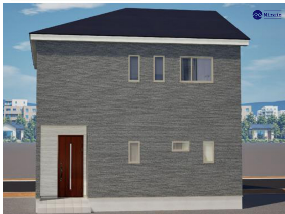
八戸市下長第9（6棟）2号棟
